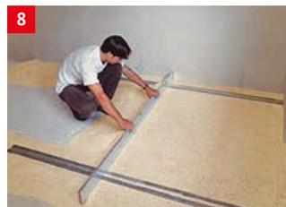
8 Von der Tür aus Abdeck- bzw. Trittschalldämmplatten auslegen. Dämmplatten untereinander dicht stoßen, Kreuzfugen vermeiden. Empfehlenswert sind Trittschalldämmplatten mit einer dynamischen Steifigkeit von 20–40 MN/m<sup>3</sup>.
