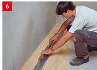
6 Auf dem Wandstreifen wird die Auflegelehre mit der Wasserwaage ausgerichtet. Im Abstand der Abziehle (ca. 10–20 cm weniger) wird ein weiterer Streifen aus BISOTHERM® Bio Trockenschüttung geschüttet, die zweite Auflegelehre aufgelegt und mit der Abziehle und Wasserwaage ausgerichtet.
