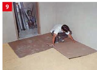
9 Den weiteren Aufbau, wie in den Anwendungsbeispielen angegeben, mit z. B. Trockenestrich oder Spanplatten nach Herstellerangaben verlegen. Dabei mind. 1 cm Abstand von der Wand einhalten.
