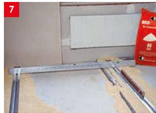
7 Vom hinteren Ende des Raumes zur Tür hin über die Auflegelehen die Trockenschüttung abziehen. Vor dem Abziehen kann die Trockenschüttung bereits leicht verdichtet werden. Installationsleitungen sollten mit mind. 12 mm überdeckt werden (dreifaches Größtkorn).
