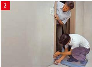
2 Vom Meterriss 1 m + Fußbodenaufbau hinuntermessen (z. B. Belag 5 mm, Spanplatte 22 mm, Abdeckplatte 8 mm) = 1,035 m.
