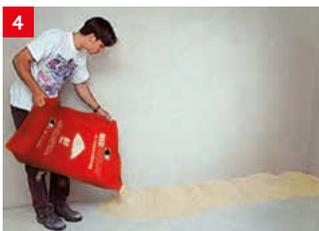
4 An der Wand BISOTHERM® Bio Trockenschüttung in ca. 20 cm Breite auf Höhe des Markierungsstriches aufschütten.
