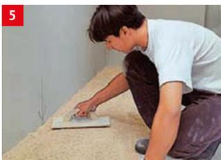
5 Mit dem Reibebrett wird die Trockenschüttung auf die Höhe des Markierungsstriches gebracht.
