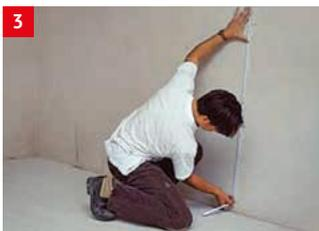
3 Höhendifferenz zur Rohdecke bzw. alten Dielenboden ermitteln (z. B. Höhendifferenz 5 cm, Schütthöhe 5,5 cm, Maß vom Meterriss 1,035 m). Maß an der Wand markieren. Verlegen Sie auch einen Randstellstreifen und, falls erforderlich, auch eine Dampfsperre.
